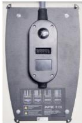
Bakplate klargjort for ladestasjon
